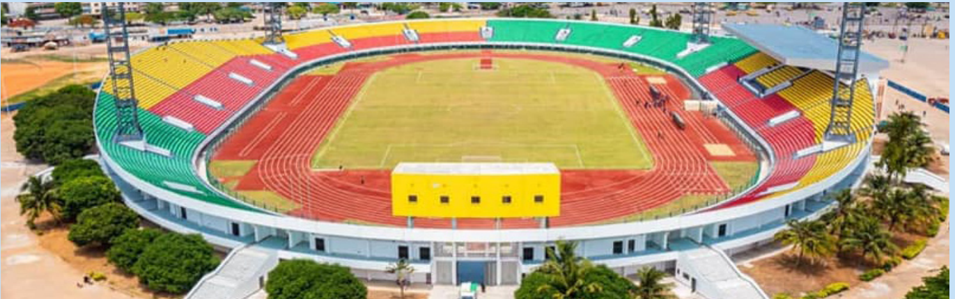
RENOVATION DU STADE GENERAL MATHIEU KEREKOU
